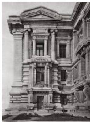
Fragment van de zijgevel gericht naar de Miniemenstraat, waarin de stapeling van kolommen en pilasters, de grootschalige profileringen van consoles, raamlijsten en frontons optimaal tot uitdrukking komt.
