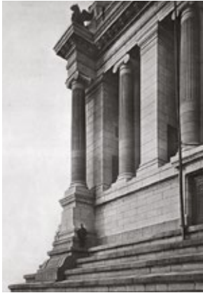
De onderbouw van de koepel: de vierkantige zuilengaanderij; bovenaan één van de griffioenen, dat zijn mythische dieren doorgaans met hoofd en vleugels van de arend, oren van het paard en in de plaats van de manen, een kam van visvinnen. Het onderlijf is dat van een leeuw.
