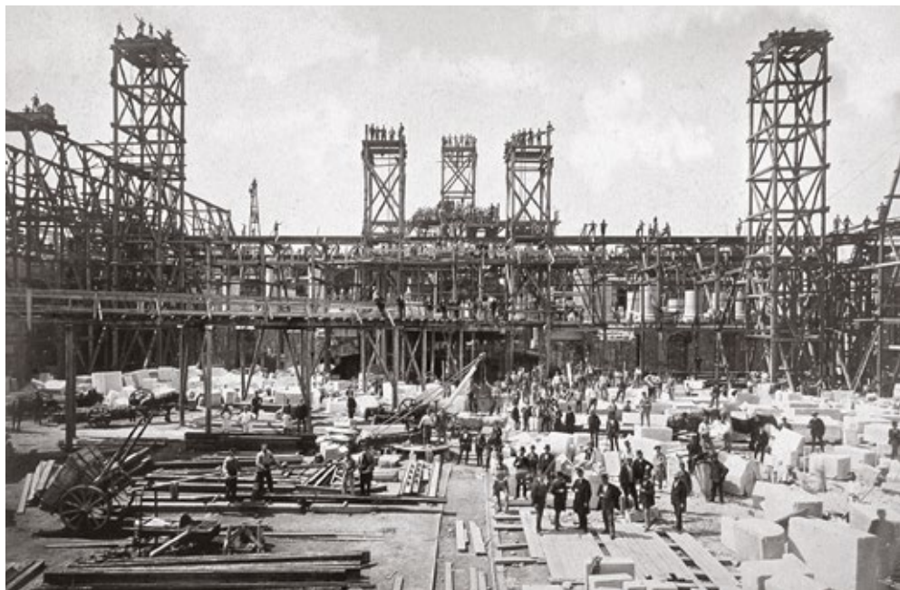
De bouwplaats en de steigerbouw.
