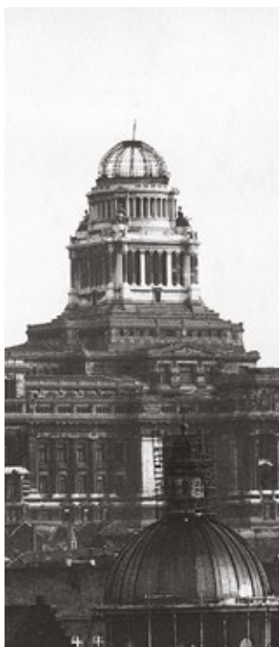
De stalen structuur van de nieuwe koepel in opbouw, naar ontwerp van ingenieur A. Storrer.
