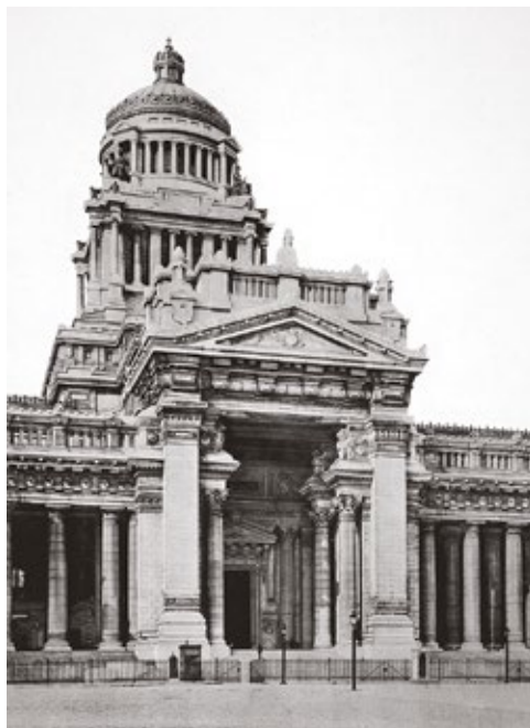
Foto en tekening van de centrale toegangsportiek met een vrije overspanning van 17,5 m, een hoogte van 27 m en een diepte van 12 m, met fronton, attiek en Athenabeeld.
