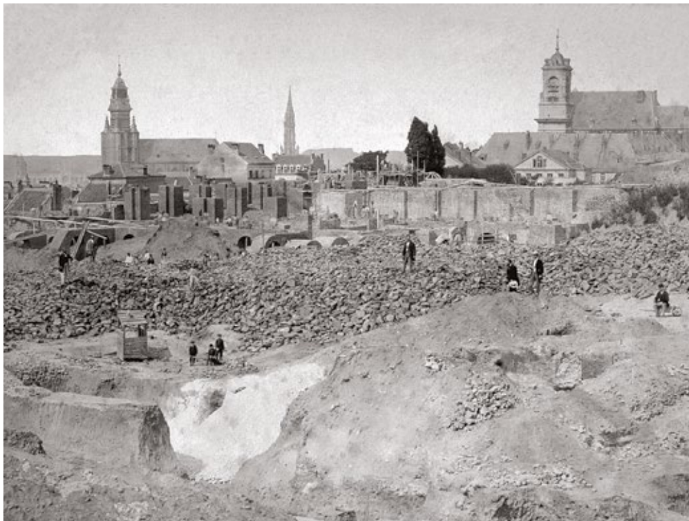
De bouwput en de grondwerken van het Justitiepaleis. Op de achtergrond v.l.n.r. de Kapellekerk, de toren van het gotische stadhuis, de Miniemenkerk.
