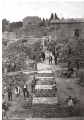
De opbouw van de funderingsmassieven en de draagstructuren voor de keldergewelven.
