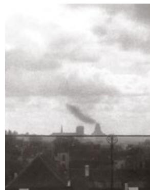
3 september 1944: enkele uren voor de bevrijding van de hoofdstad staken de Duitsers de koepel van het Justitiepaleis in brand met vaten benzine en explosieven.
